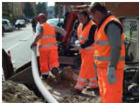
POSA DEI CAVI
