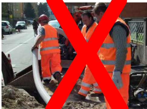
POSA DEI CAVI
