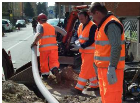
POSA DEI CAVI
